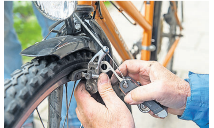
Ordentlich zugreifen: Damit Fahrradbremsen genau das tun können, raten Experten zum regelmäßigen Check und Austausch verschlissener Beläge.
