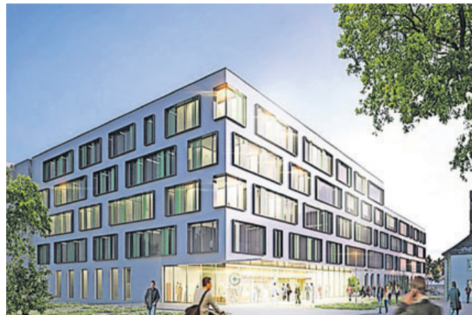
So wird es in vier Jahren am Hochwaldklinikum Bad Nauheim aussehen.
