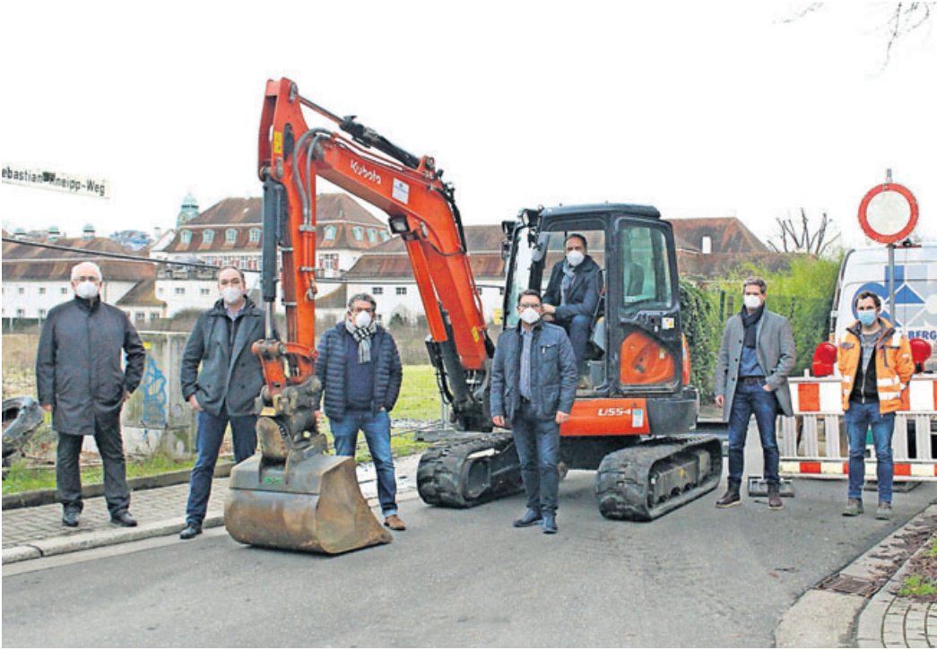
Thomas Wetzel, Sven Nuhn, Jürgen Patscha, Peter Drausnigg, Klaus Kreß, Matthias Mroncz und Christopher Gruber mit dem ersten Baufahrzeug für die Leitungsverlegung.
