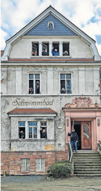
Der Umbau des Alten Hallenbades in Friedberg kann beginnen.
