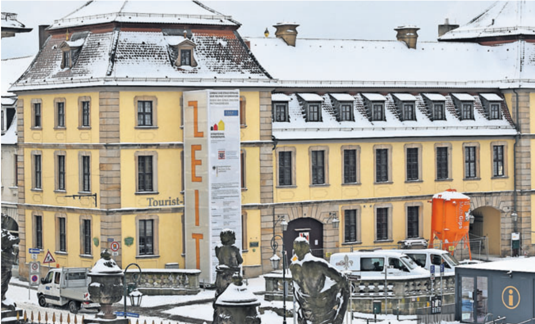
Die Baustelle der Tourist Information.
