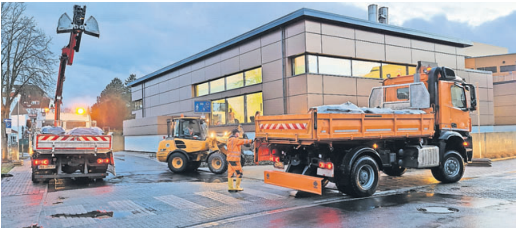
Mitarbeiter des Bauhof bei den ersten Aufräumarbeiten.
