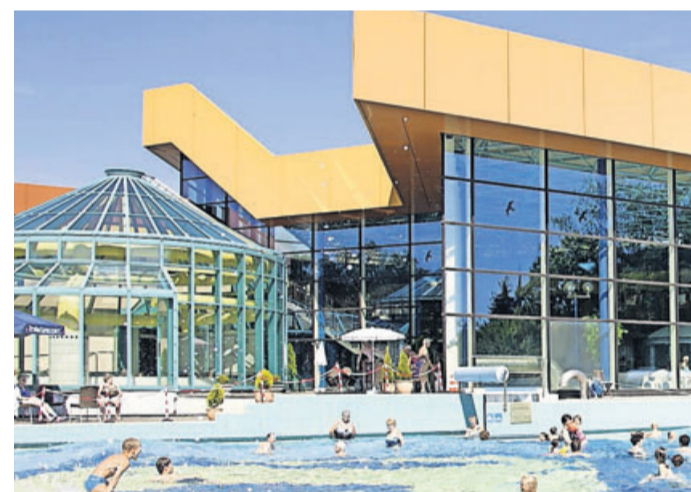
Die Spessart-Therme wird saniert.
