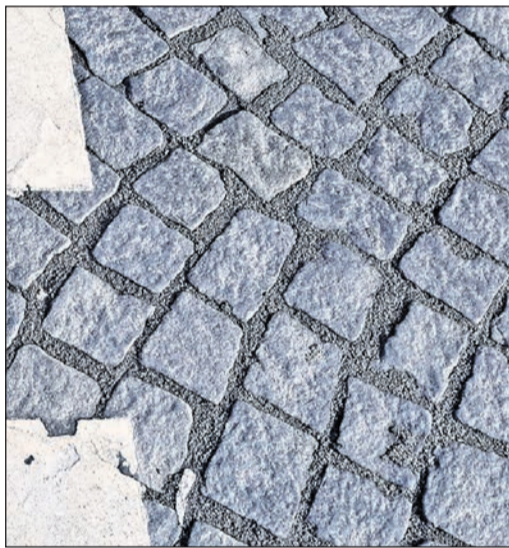
Die Holperstrecke am Marktplatz könnte nach ersten positiven Tests komplett verharzt werden. Foto: js
