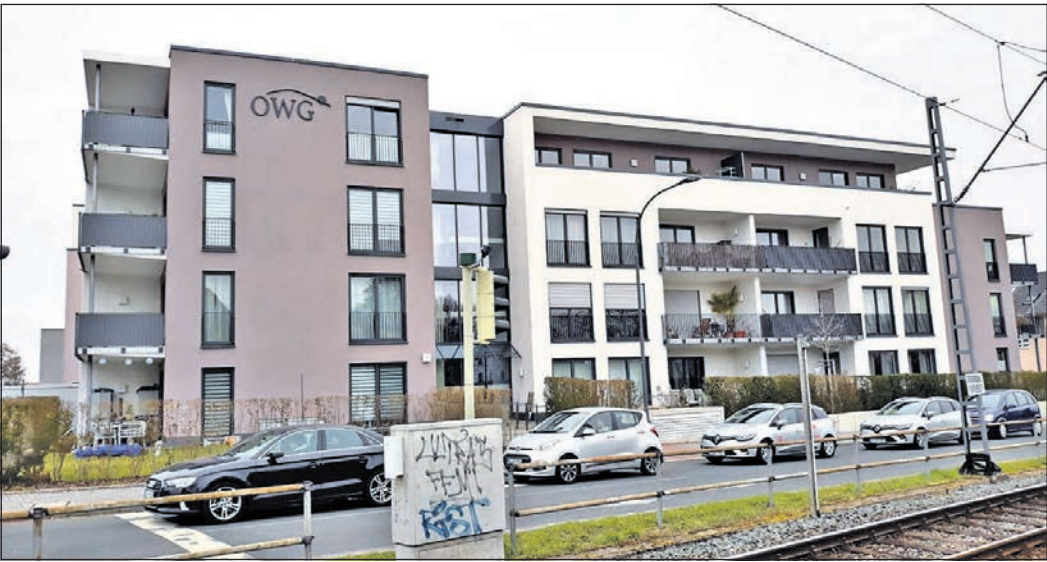
Beim OWG-Projekt an der Ecke Berliner Straße/Freiligrathstraße konnte die Initiative „Wohntraum“ erstmals einsteigen. Foto: js
