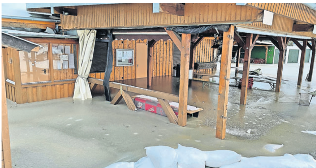
Das Hochwasser hat viele Gebäude zerstört.
