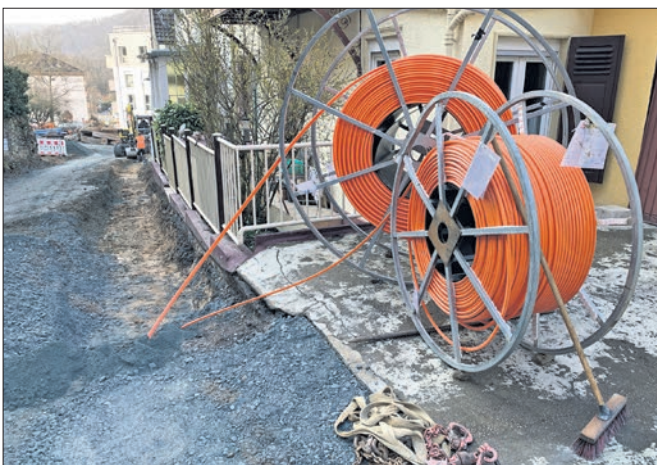
In der Gimbacher Straße werden Leerrohre für Glasfaser verlegt.
