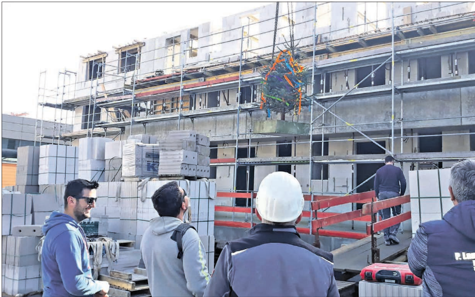
Der Rohbau für das Wohnprojekt an der Urseler Straße mit 49 Wohnungen ist geschafft, Zeit für ein kurzes Innehalten auf der Baustelle und für Speis und Trank mit allen Beteiligten und Gespräche am Rande, während der Richtbaum in die Höhe schwebt. Fotos: Streicher
