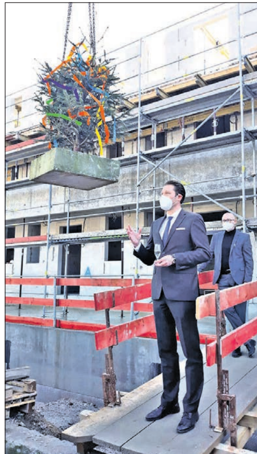
Ein Prost auf den „Meilenstein für das Gesamtareal“ von OB Alexander Hetjes, fürs Foto wird der Richtbaum noch einmal abgelenkt. Im Hintergrund der Geschäftsführer der Wohnungsbau GmbH, Karsten Valentin.
