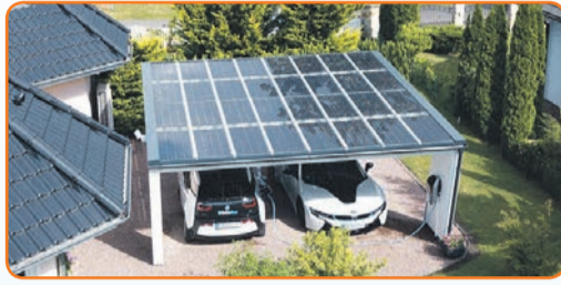
Abstellplatz und E-Tankstelle in einem: Ein Carport mit Solardach bietet gleich mehrfachen Nutzen.
