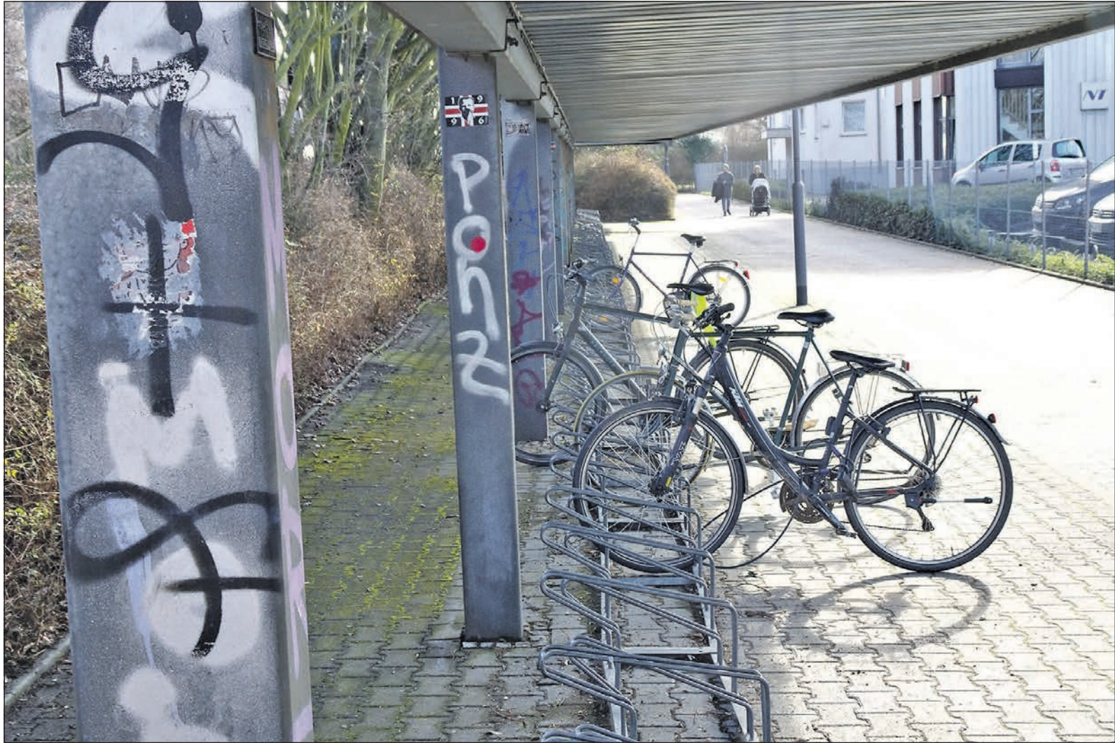
Mit der gammeln Fahrradgarage am S-Bahnhof soll es bald vorbei sein. Umfassende Sanierungen und moderne Installationen mit Ladestation und „Servicepoint“ versprechen eine bessere Zukunft. Foto: HB
