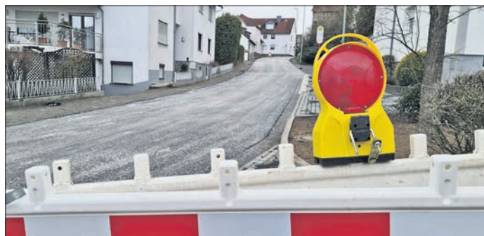
Die frisch asphaltierte Niederjosbacher Straße. Foto: Stadt Eppstein
