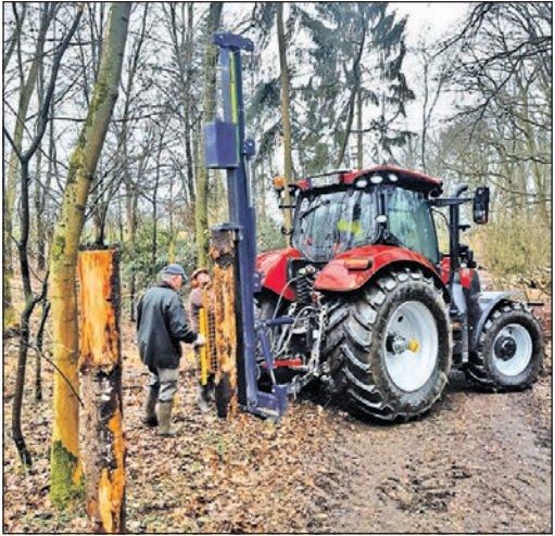
Mit schwerem Gerät werden die neuen Pfosten für den Zaun eingerammt.
