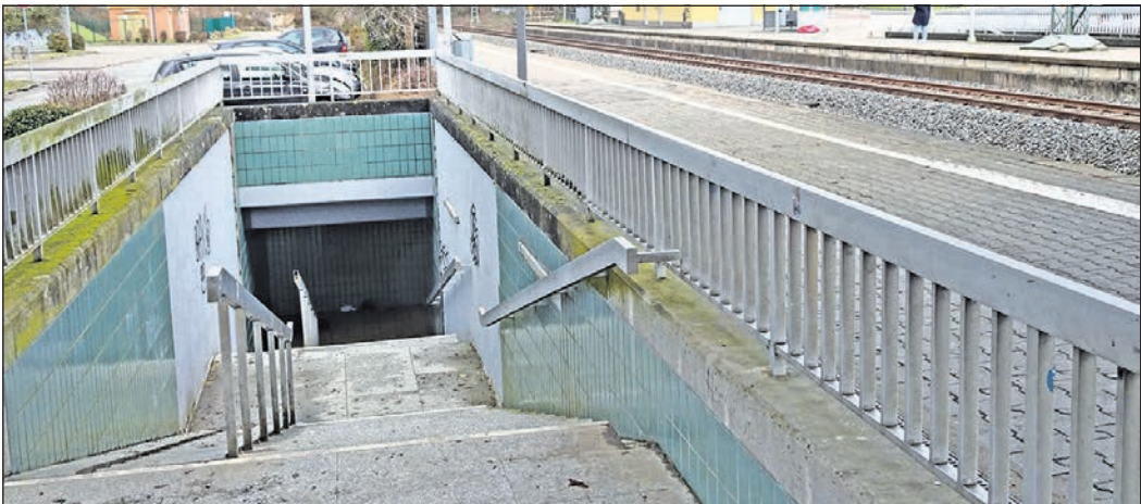
Der S-Bahnhof Weißkirchen-Steinbach hat die Sanierung nötig.
