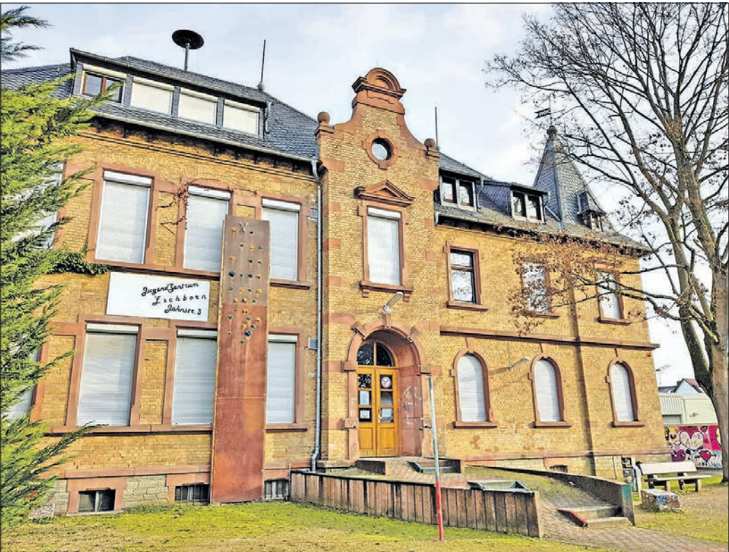
Das Gebäude in der Jahnstraße 3 - neues Kulturzentrum. Foto: Stadt Eschborn
