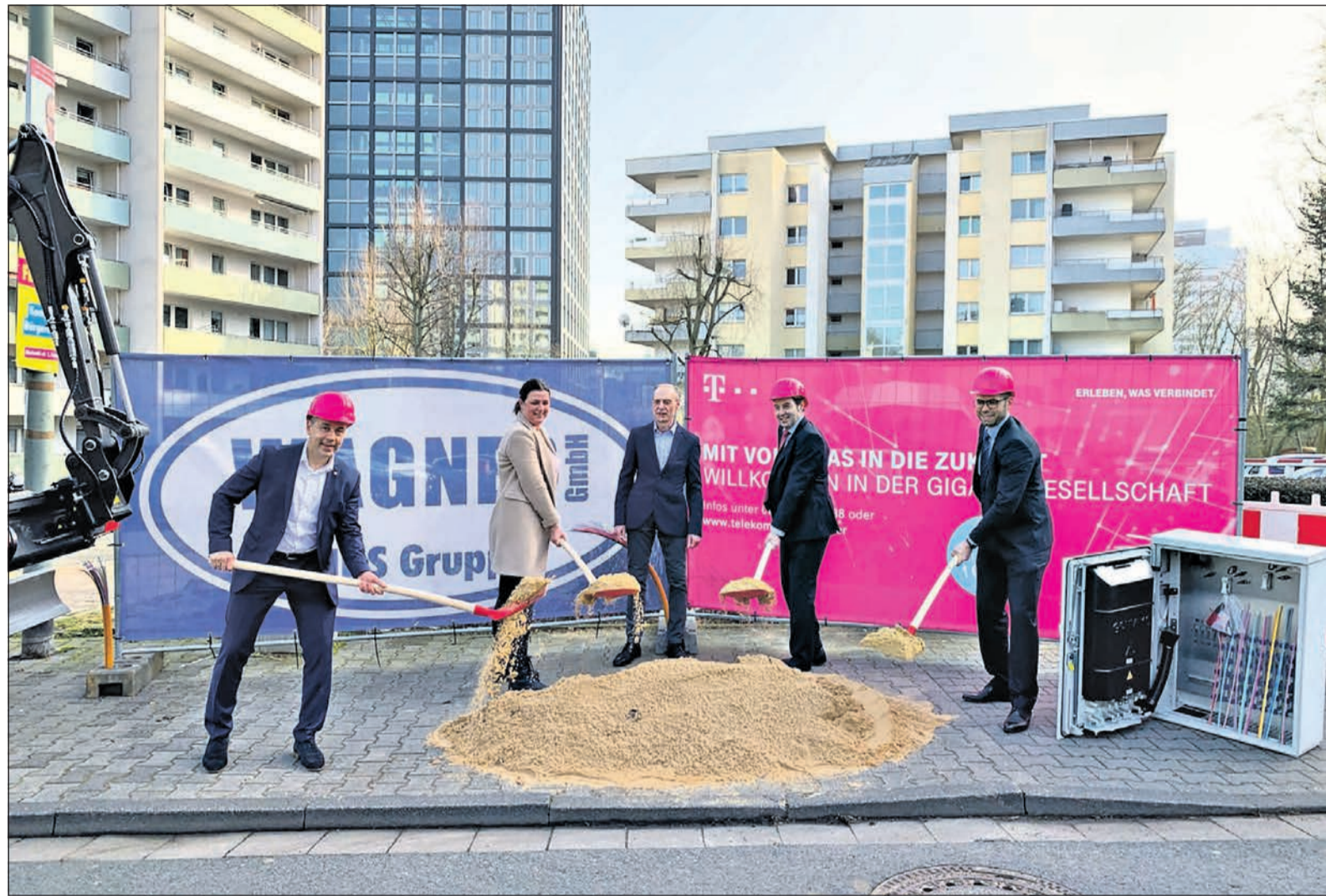
Bürgermeister Adnan Shaikh, Darija Budimlic vom Tiefbau der Stadt Eschborn, Hans Czorny, Michael Löttner und Fuat Dalar von der Telekom (v. l.) haben den ersten Spatenstich vollzogen. Foto: Hassnat Ahmad
