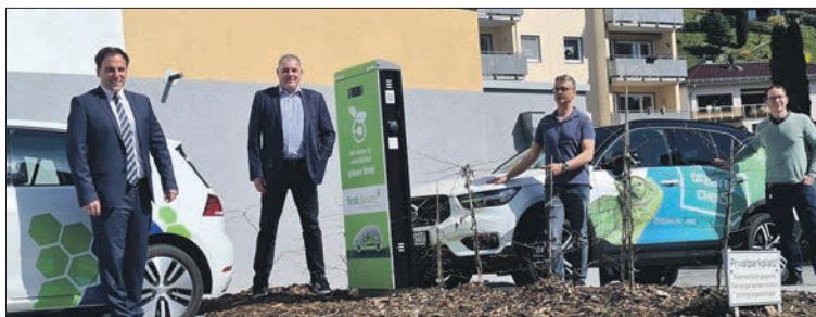
Weitere Elektro-Ladesäule am Wohnpark Müllerwies: Bürgermeister Alexander Simon mit Michael Lindhof, Matthias Werner und Julian Schirm (v.l.) bei der Inbetriebnahme. Foto: Stadt Eppstein
