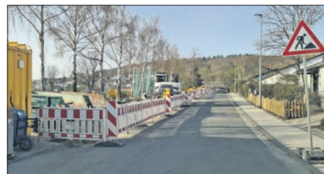
Das Baustellenlager Auf dem Wingertsberg wird derzeit beseitigt. Foto: Stadt Eppstein
