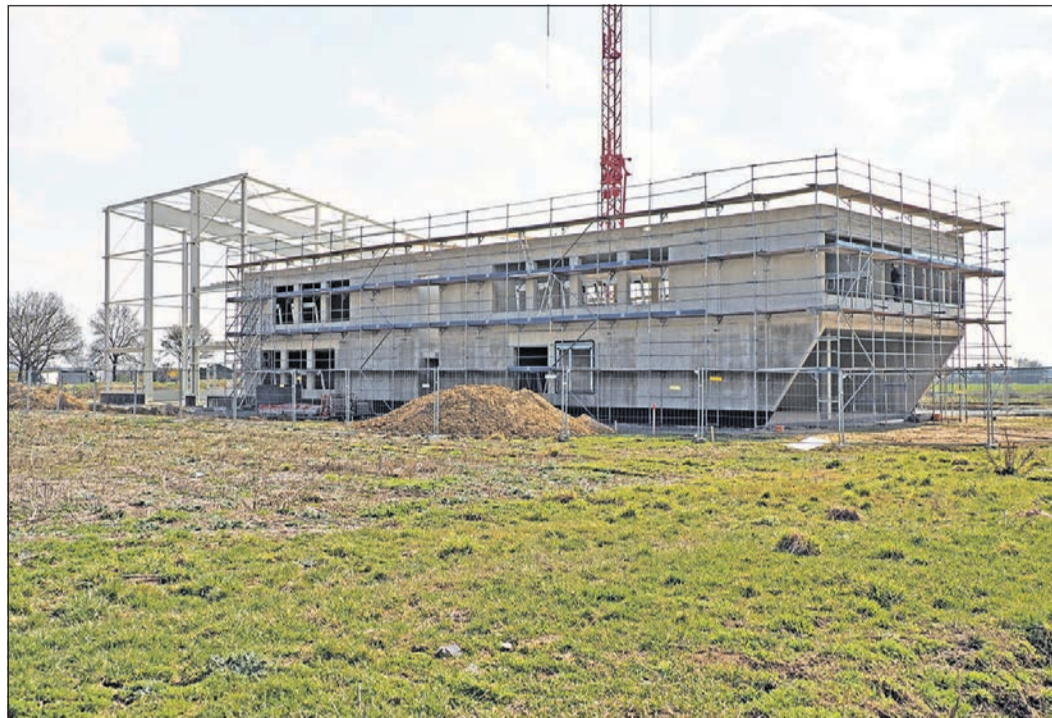
Wie ein Flaggschiff mutet das entstehende Manitougebäude an. An das Verwaltungsgebäude schließt sich (links auf dem Foto) eine 460 Quadratmeter große Lagerhalle an, die mit Metallsandwichelementen in „Manitou-Rot“ verkleidet werden soll. Foto: fwh
