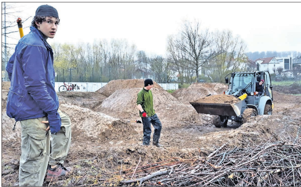
Malte Klein arbeitet mit Malte Stockmann und „Baggerfahrer“ Laurin (v. l.) an der Dirt-Bike-Bahn. Laurin sitzt zum ersten Mal im Führerhaus und stellt fest, dass es gar nicht so einfach ist, die Schalthebel der Macht über solch schweres Gerät zu bedienen. Foto: js
