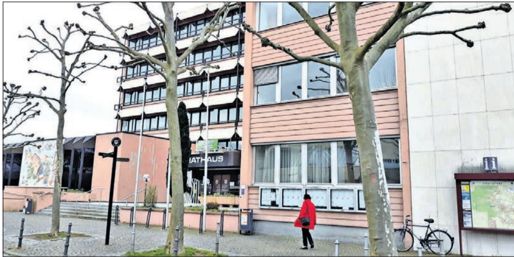
Auch über die Sanierung des Rathauses wird in der neuen Wahlperiode im Stadtparlament noch des Öfteren zu sprechen sein. Foto: js
