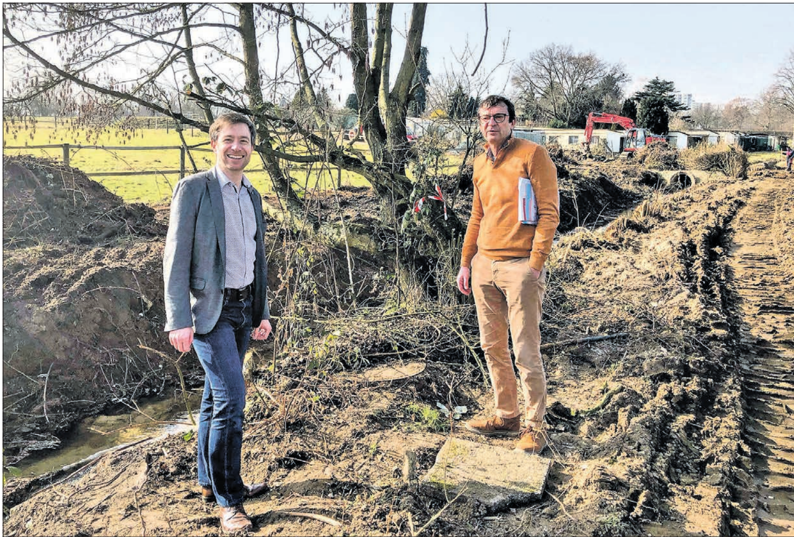
Begutachten die Fortschritte bei der Renaturierung des Steinbachs: Bürgermeister Steffen Bonk und Bauamtsleiter Alexander Müller (v. l.) im Abschnitt 3b, in dem der Bach zukünftig nicht nur mäandert, sondern sich auch mit neuer Bepflanzung präsentiert. Foto: Sebastian Köhler
