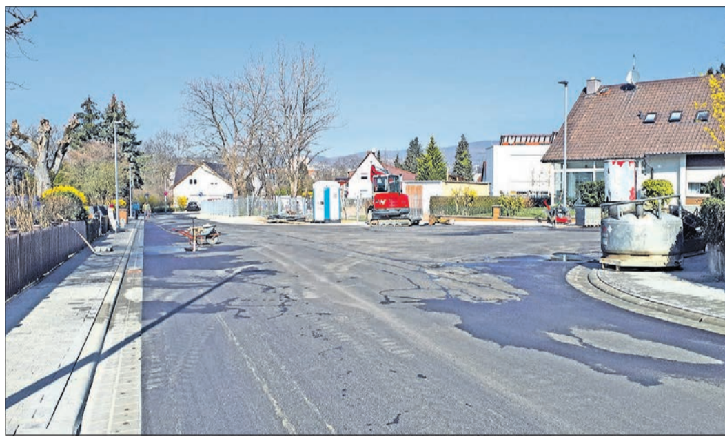
Die Bauarbeiten in der Höchster und Schwanheimer Straße sind weitestgehend und wie geplant abgeschlossen. Foto: Stadt Schwalbach
