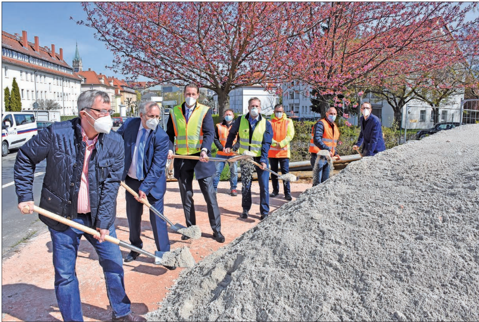
Für den offiziellen Spatenstich greifen (v. l.) Thomas Meye, Meinhard Matern, OB Alexander Hetjes, Ralf Schroedter, Markus Philipp und Elmar Waldmann zu den Schaufeln. Foto: Stavenow
