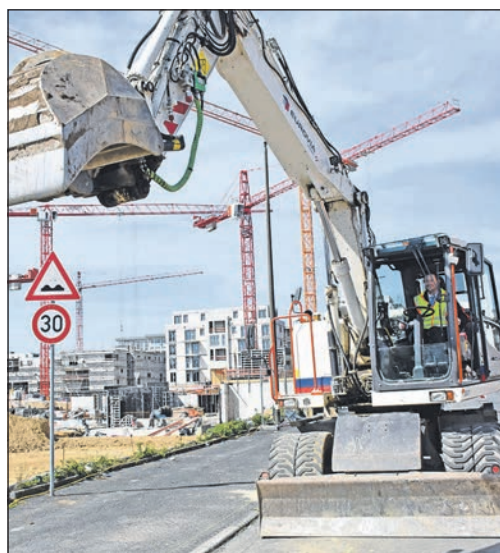
Für OB Alexander Hetjes der große Moment: Vor der Kulisse des Baugebiets darf er den Bagger steuern. Foto: Stavenow
