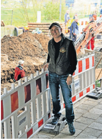
Matthias Bremer schaute sich vor Ort in der Wiesengasse den Baufortschritt der ersten Woche an.
