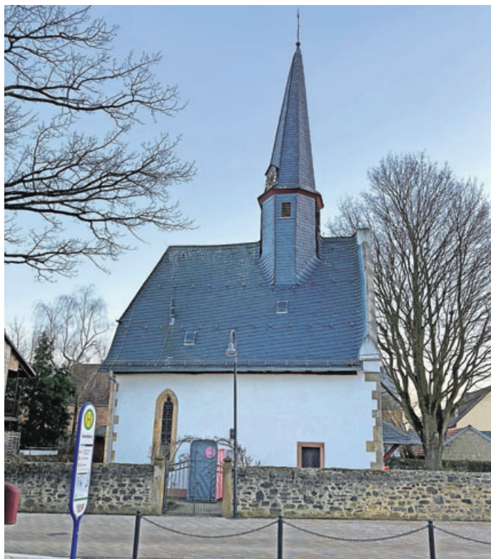
Die Heuchelheimer Kirche wird derzeit saniert, auch die Außenanlage wird im Zuge der Arbeiten neugestaltet.
