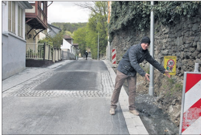
Florian Albers zeigt, wo die Natursteinmauer abgestützt werden muss.
