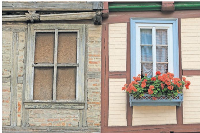
Bei denkmalgeschützten Fachwerkhäusern unterliegt die energetische Sanierung Auflagen - so darf hier etwa nicht die Dämmung außen auf die besondere Fassade kommen.
