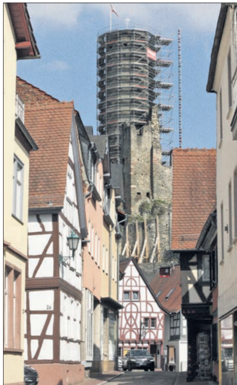
Der Burgturm ist aufwändig eingerüstet, massive Stützen sichern die Mauer über der Altstadt.
