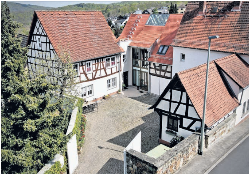
Die alte Hofreite in Bremthal wurde saniert. Die Besitzer bauten die Scheune (mittleres Gebäude) samt Verbindung zum alten Wohnhaus (links) aus. Foto: Weiss/MTK
