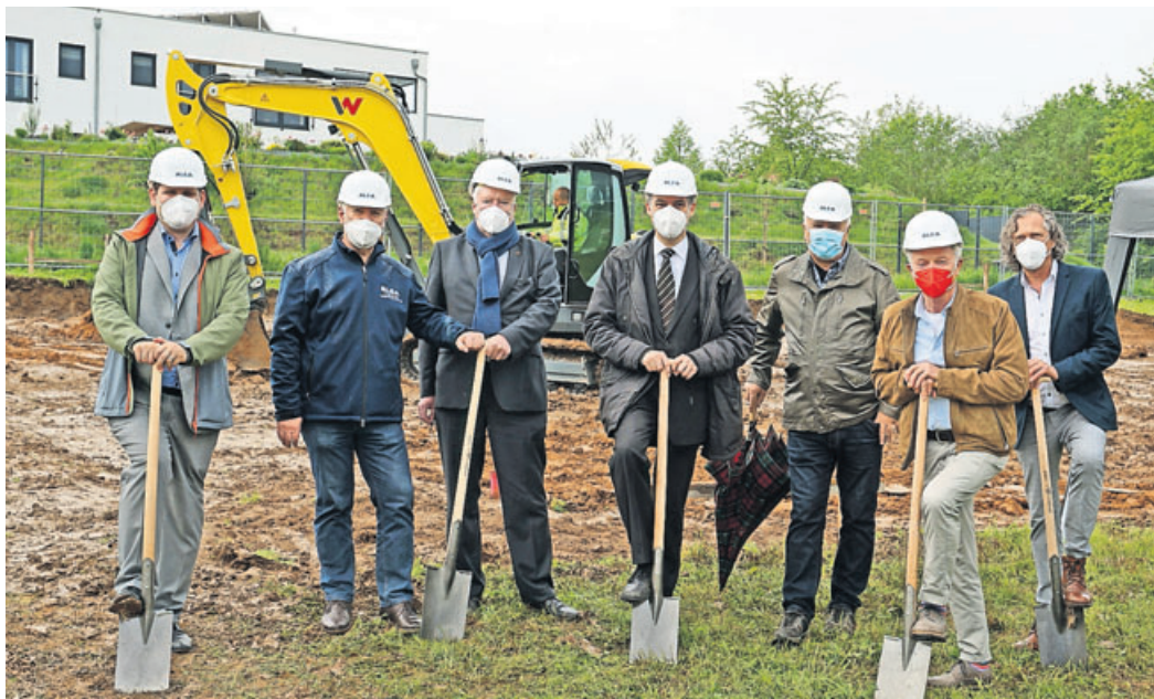
Freuen sich gemeinsam über den ersten Spatenstich des Heilsberger Jugendhauses: Vertreter des Magistrats, des Ortsbeirats und der ausführenden Baufirma.
