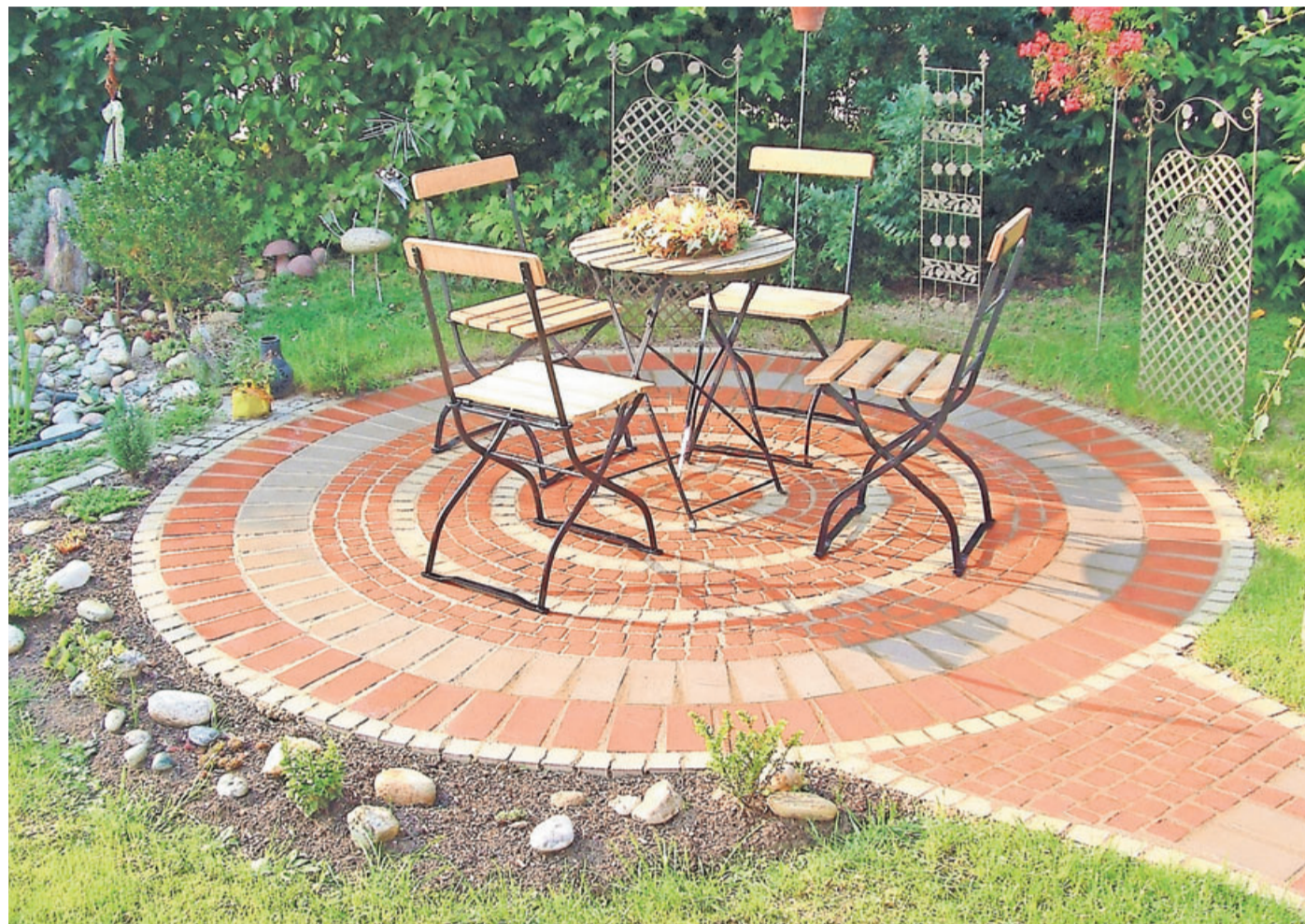
Quadratische und rechteckige Pflasterklinker, in Kreisform verlegt, gestalten diesen Lieblingsplatz im Freien.
