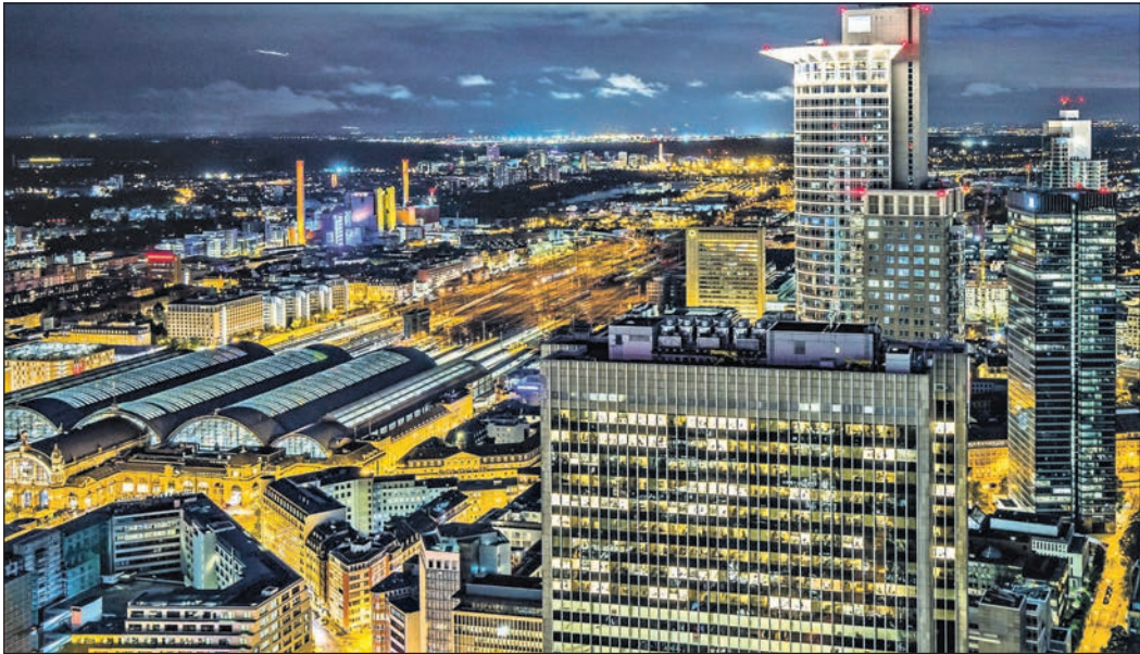
Den Frankfurter Hauptbahnhof mit seinen unzähligen Lichtern hat Joachim Steurer im Foto festgehalten. Foto: Steurer
