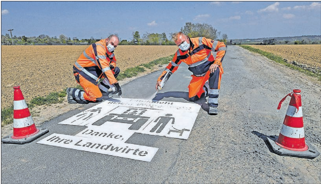
Christian Merwa (l.) und Volker Günther, beide Mitarbeiter des städtischen Betriebshofs, bringen mit einer Schablone auf einem Feldweg in der Nähe der Straße „Am Pilgerrain“ eine Markierung auf. Foto: fk
