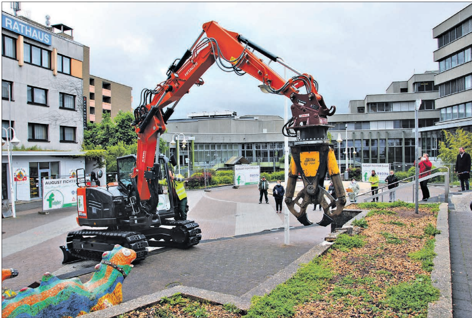
Mit einer symbolischen „ersten Bagger-Schaufel“ beginnen die Bauarbeiten zur Umgestaltung des unteren Marktplatzes. Die Fertigstellung ist gegenwärtig für Februar 2022 geplant. Foto: Stadt Schwalbach
