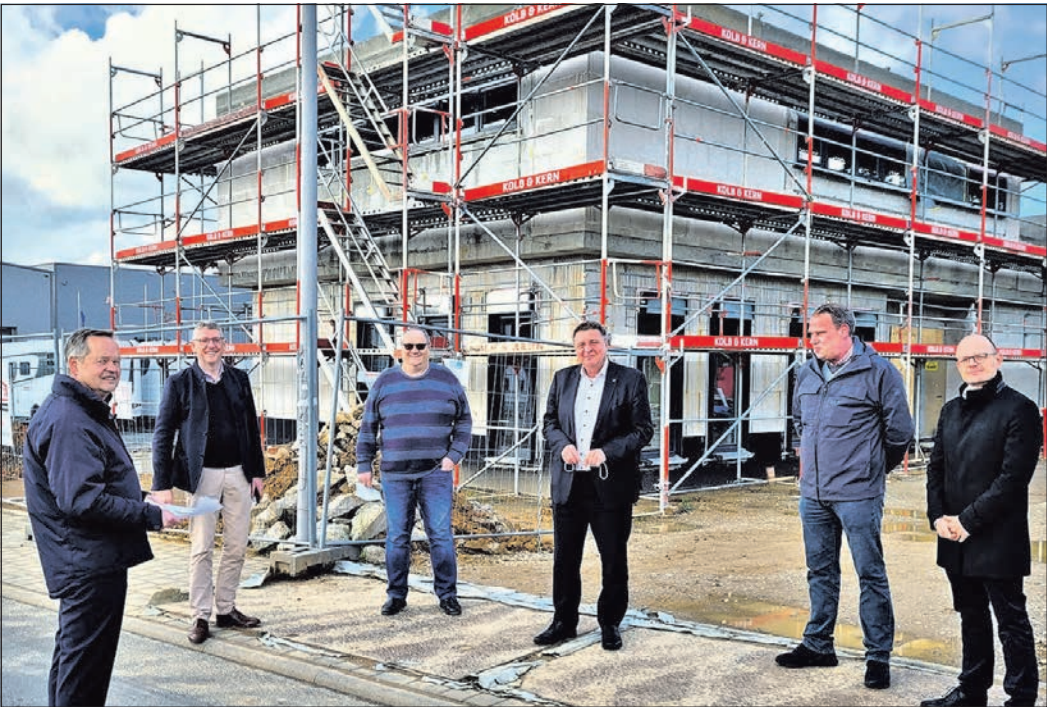
Der Vorstand des DRK-Kreisverbands Hochtaunus überzeugt sich im Köpperner Gewerbegebiet Nord-Ost vom Baufortschritt der neuen Rettungswache. Man hofft auf eine Einweihung im Oktober. Foto: DRK-Pressestelle
