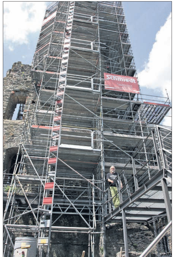
Etage für Etage muss Burgenforscher Joachim Zeune die Außenmauer des Burgturms zeichnen und kartieren.
