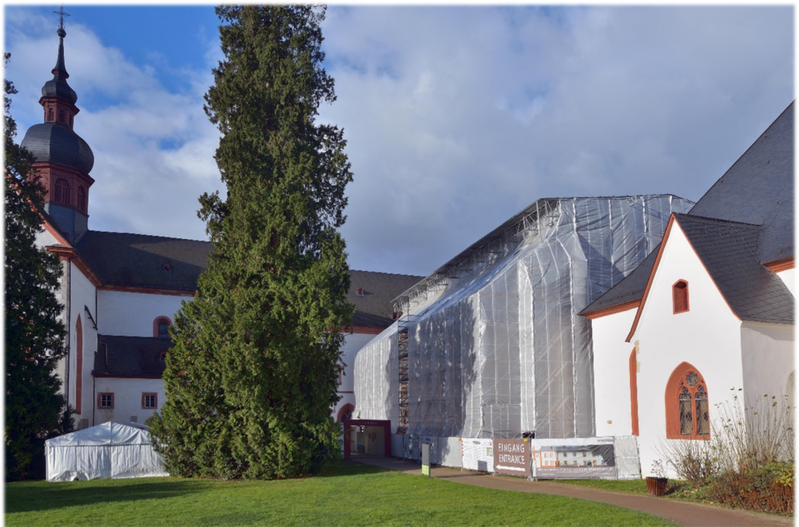
Gerüstbau Fr. Schimmer GmbH: Kloster Eberbach, Eltville am Rhein
