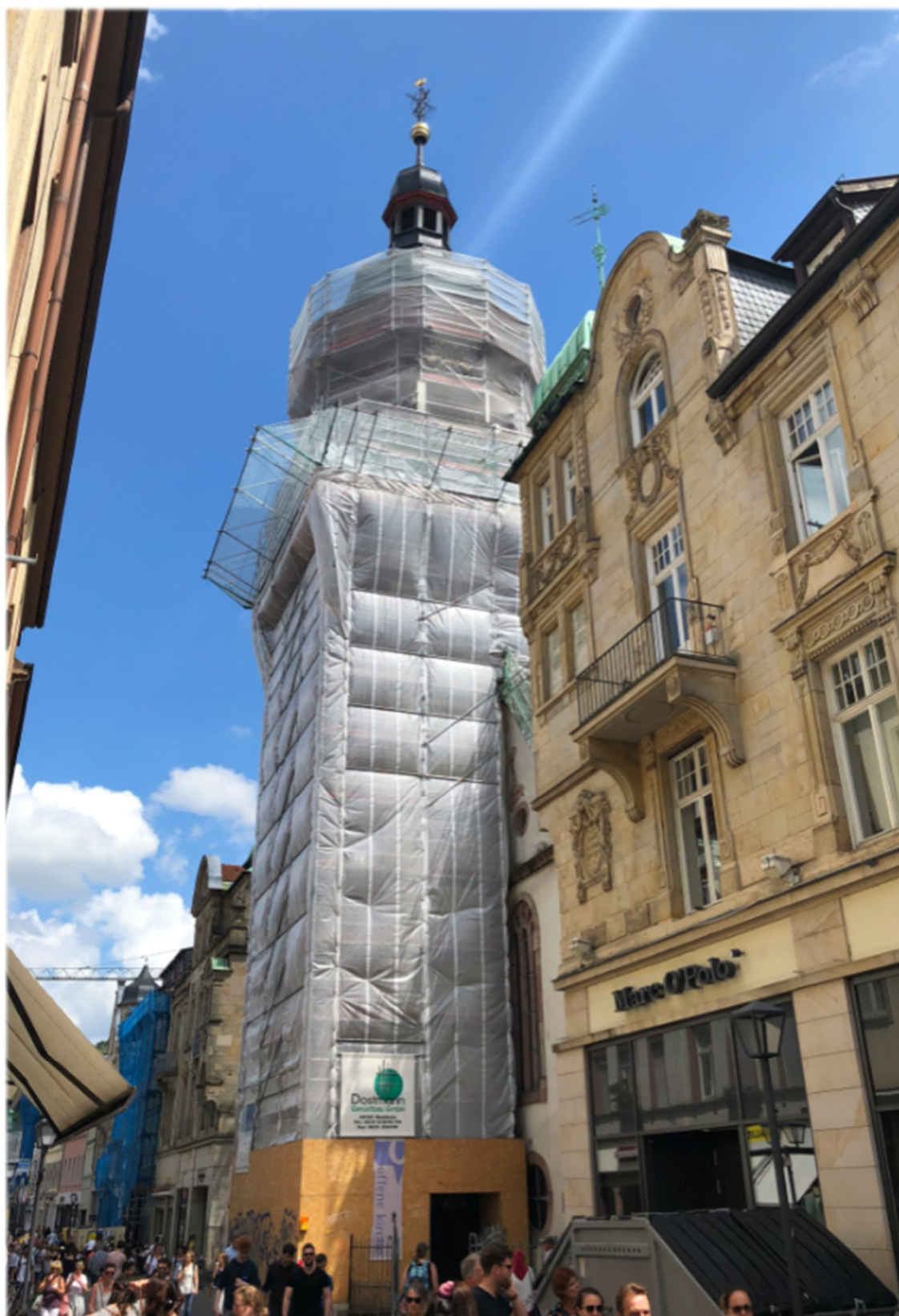
Gerüstbau Dostmann GmbH: Providenzkirche, Heidelberg
