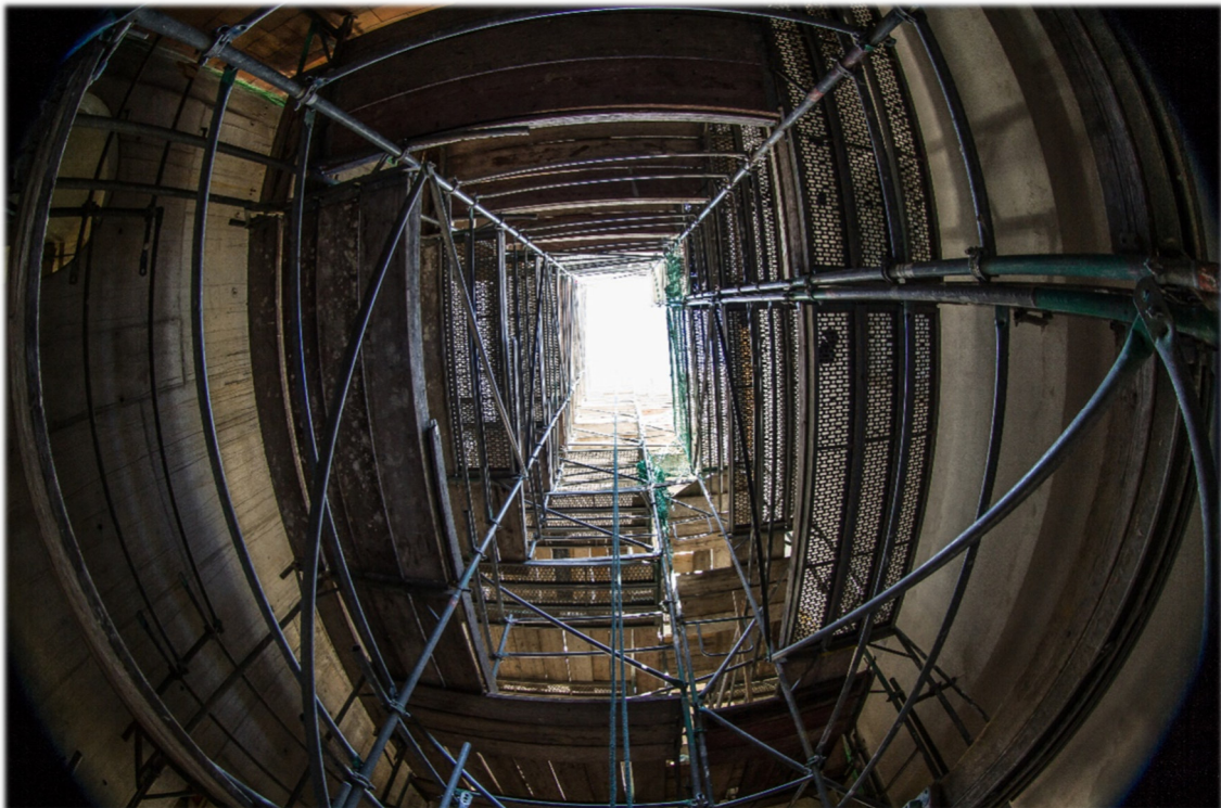
Gerüstbau Paul GmbH: Neue Altstadt Dom-Römer, Lichthof Hinter dem Lämmchen/Braubachstraße, Frankfurt
