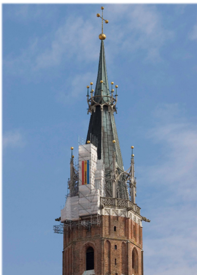
Sax Gerüstbau GmbH: Stiftsbasilika St. Martin, Landshut
