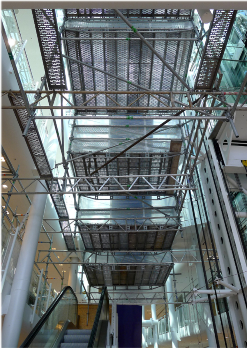
Gerüstbau Dostmann GmbH: Hängegerüst Rolltreppen Zeilgalerie, Frankfurt am Main
