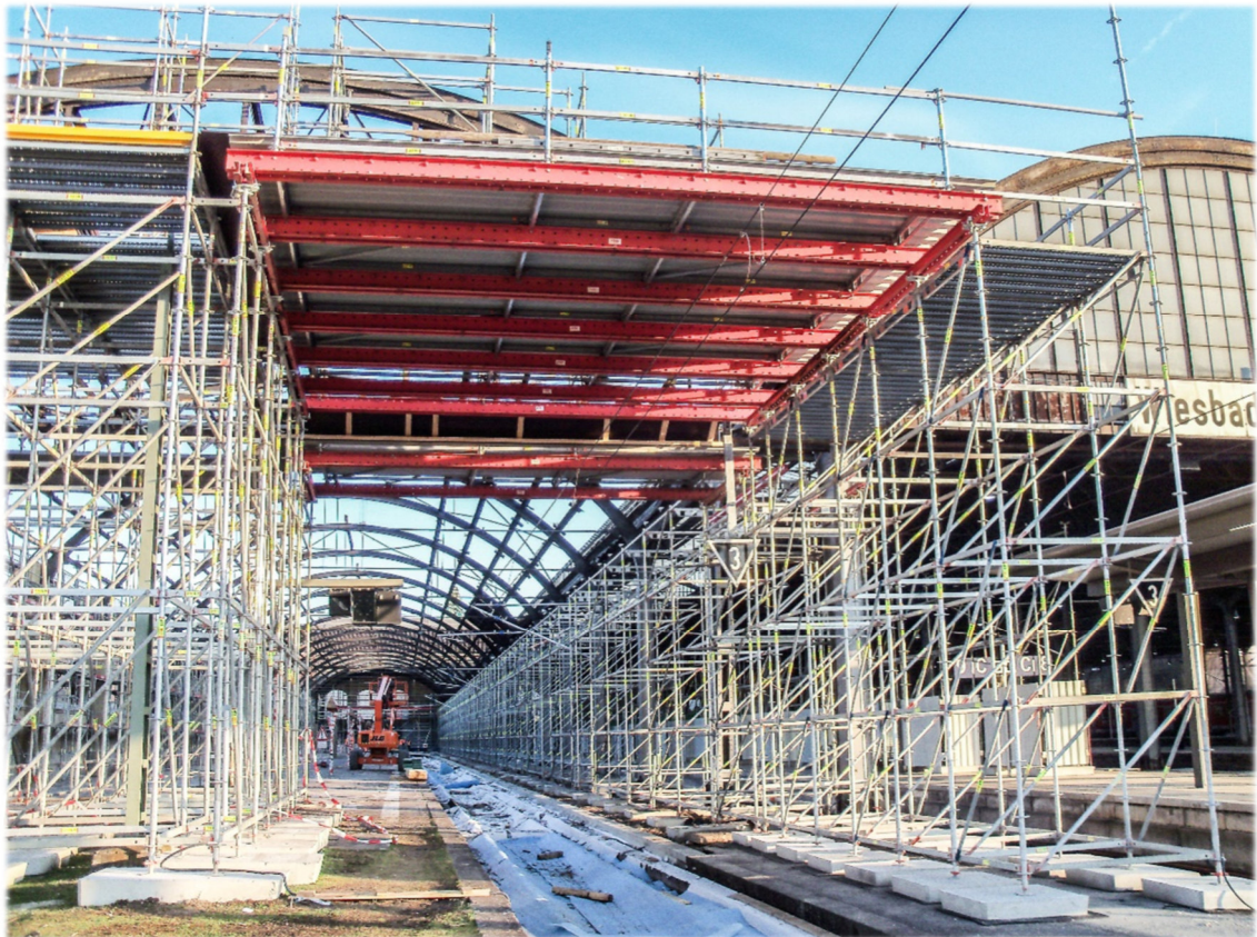
Gerüstbau Paul GmbH: Hauptbahnhof, Wiesbaden
