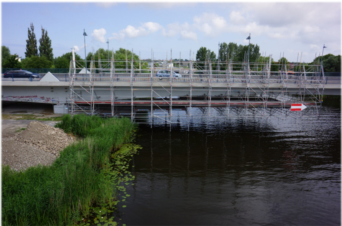
Gerüstbau Mank GmbH: Vorpommern Brücke, Rostock
