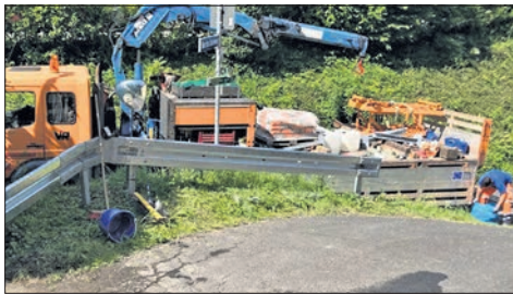
Montage der neuen Planke. Stadt Eppstein
