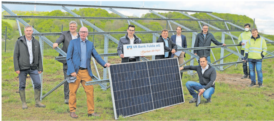
Mit der symbolischen Modullegung geht es in die intensive Bauphase: Partner und Unterstützer des Projekts freuen sich gemeinsam mit Torsten Eurich (Geschäftsführer next energy; vorne kniend) und Steinaus Bürgermeister Christian Zimmermann (links hinten). Foto: Denter
