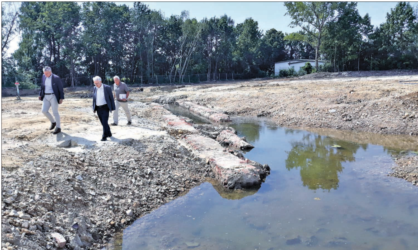
Ortsbesichtigung im Ödland am Rand der Urselbachaue. Von Pecan-Geschäftsführer Markus Brod lassen sich Bürgermeister Hans-Georg Brum und Stadtplanungschef Arnold Richter (v. l.) über den Stand der Dinge bei der Boden- und Grundwassersanierung unterrichten. Im Hintergrund der Schutzstreifen am Bachrand, der wohl auch zum Teil abgetragen werden muss. Foto: js
