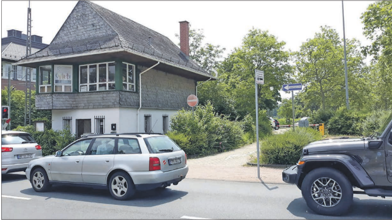
Einfahrt zum neuen Wohnglück zwischen U- und S-Bahn. Das alte Schrankenwärterhäuschen mit Denkmalschutz darf bleiben, daneben geht es ziemlich schnell in die Tiefgarage, für Autos ist kein Platz auf dem „schmalen Handtuch“, wo die Wohnblöcke entstehen. Fotos: js
