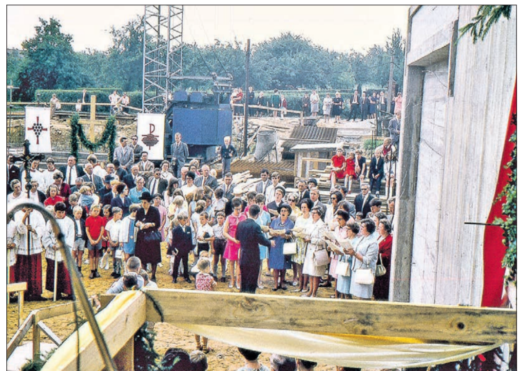
Feierlicher Gesang begleitet den Baubeginn und die Grundsteinlegung der neuen Kirche St. Sebastian in Stierstadt 1969. Fotos: Pfarrei St. Sebastian
