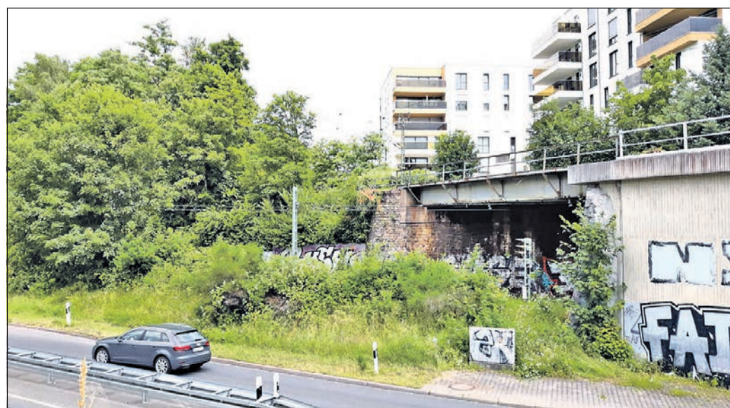
Begegnung im spitzen Winkel des Gleisdreiecks: Hier treffen sich U-, S- und „Autobahn“ und bald ein siebengeschossiger Wohnturm. Foto: js
