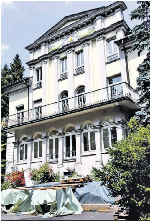
Der Charme der einst wunderbaren Villa mit der besonderen Fassade aus den Anfangsjahren des 20. Jahrhunderts hat in den vergangenen Jahrzehnten arg gelitten. Foto: js
