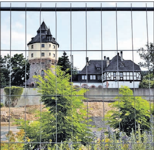
Blick durch den Bauzaun an der Basler Straße auf den Wasserturm samt Anbau. Foto: js
