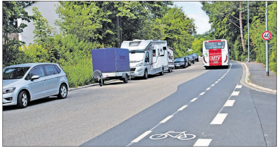
Zusätzliche Fahrradschutzstreifen gibt es jetzt auch in den oberen Bereichen des Ost- und Weststrings. Foto: Stadt Schwalbach
