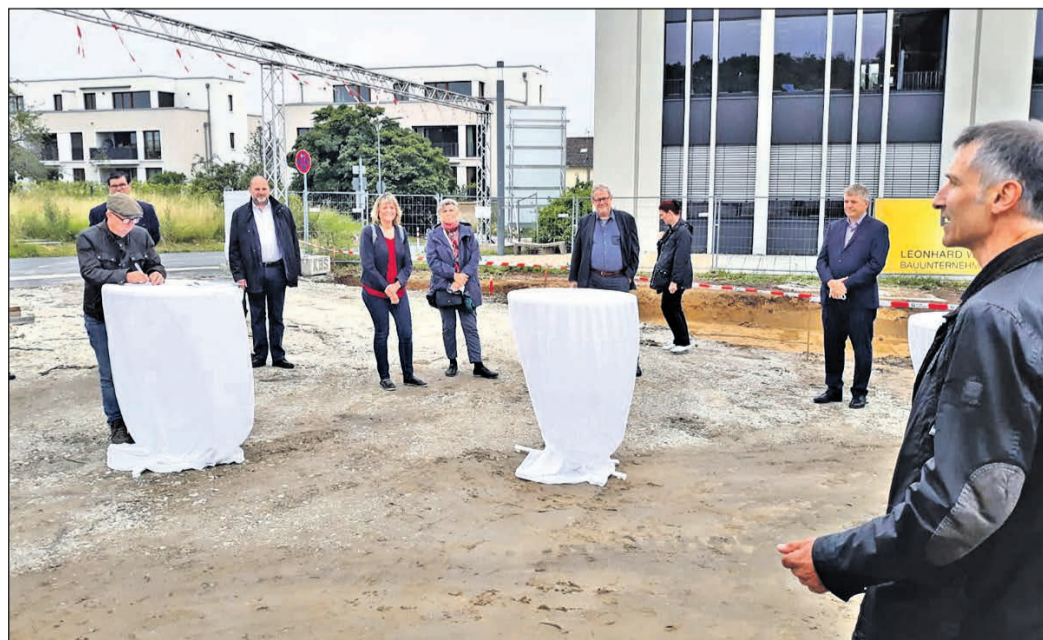
Mit Abstand auf der Baustelle: Architekt Dirk Pussert aus Dresden (r.) erläutert den angereisten politischen Vertretern und der IGS-Schulleitung das Neubauprojekt. Foto: js
