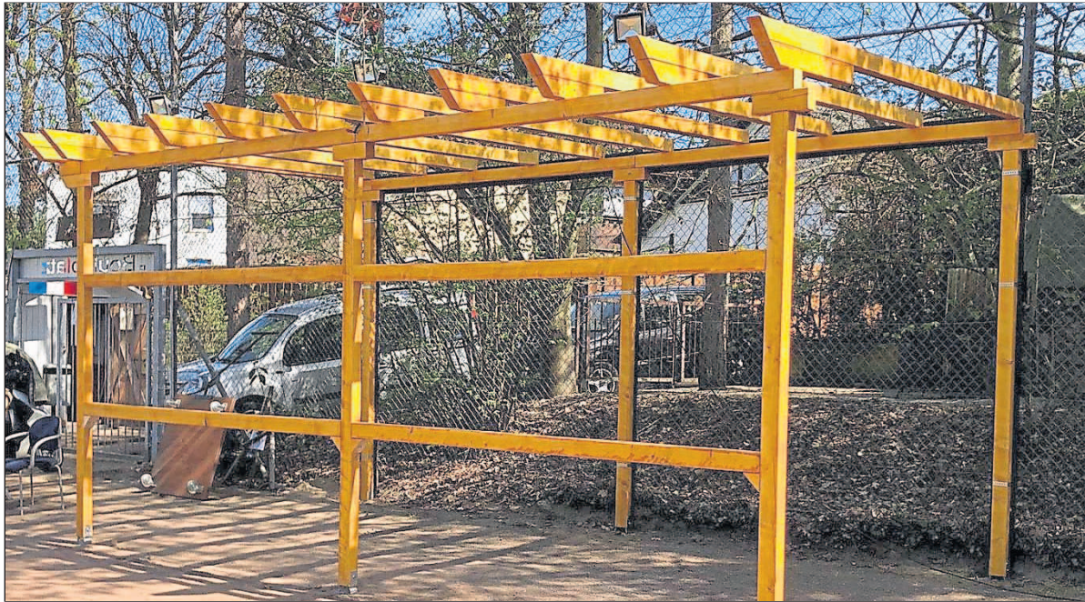
Der erste Bauabschnitt (Cateringbereich) als Ersatz für die zerstörten Festzelte.
