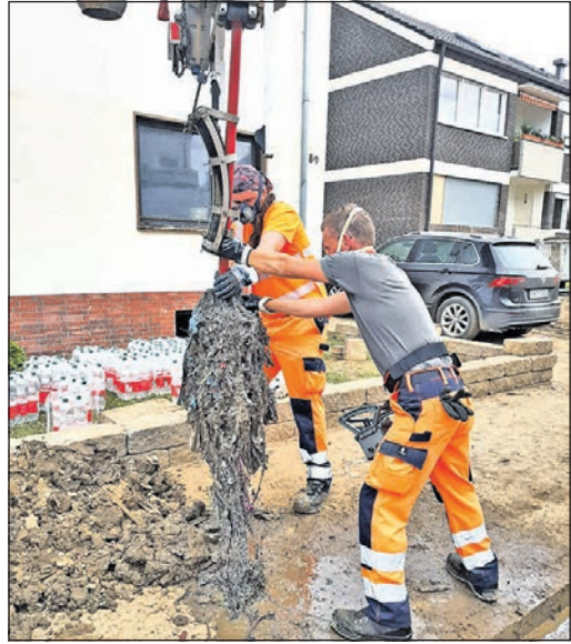
Mit einem Spezialfahrzeug werden vor allem Kanäle freigesaugt und gespült sowie Keller abgesaugt. Foto: Stadt
