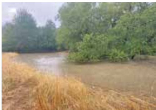
Das eingestaute Hochwasserrückhaltebecken Niederdorfsbach am 14. August 2020.
