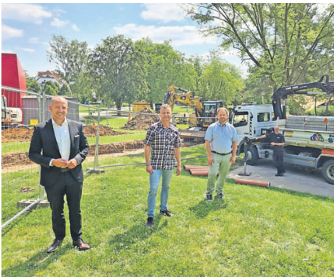
Die Bauarbeiten Outdoor Campus laufen: Bürgermeister Dominik Brasch (von links) freut sich mit ActiVita-med-Geschäftsführer Stefan Cryns und Kurdirektor Stefan Ziegler über das neu entstehende Angebot im Kurpark von Bad Soden-Salmünster.
