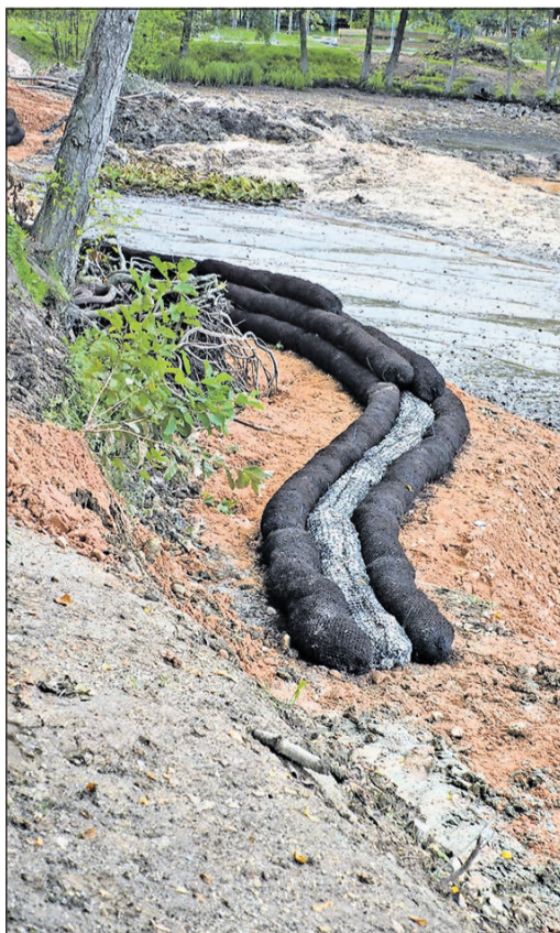
Langlebige Xylitwalzen passen sich perfekt ans Ufer an, sind ideal zur Befestigung von Böschungen und besitzen eine große Filterwirkung. Foto: fch
