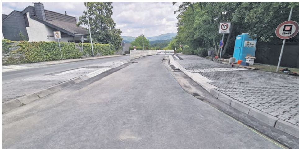
Die frisch fertiggestellte Bushaltestelle in der oberen Waldallee in Bremthal. Foto: Stadt Eppstein
